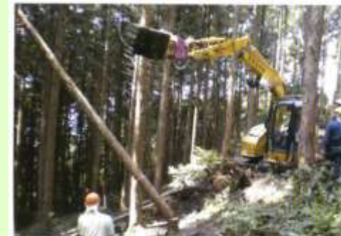
作業路作設と平行した先行伐倒
