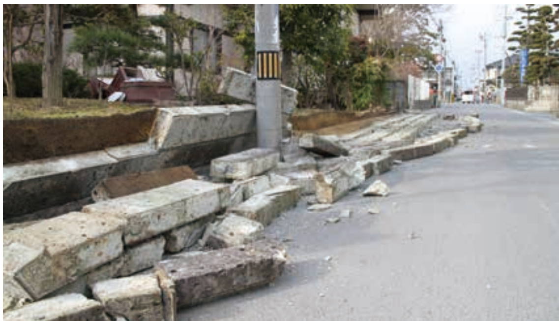
津波を免れた内陸の地域でも、ブロック塀の倒壊などが相次いだ。(祝田東地区)
