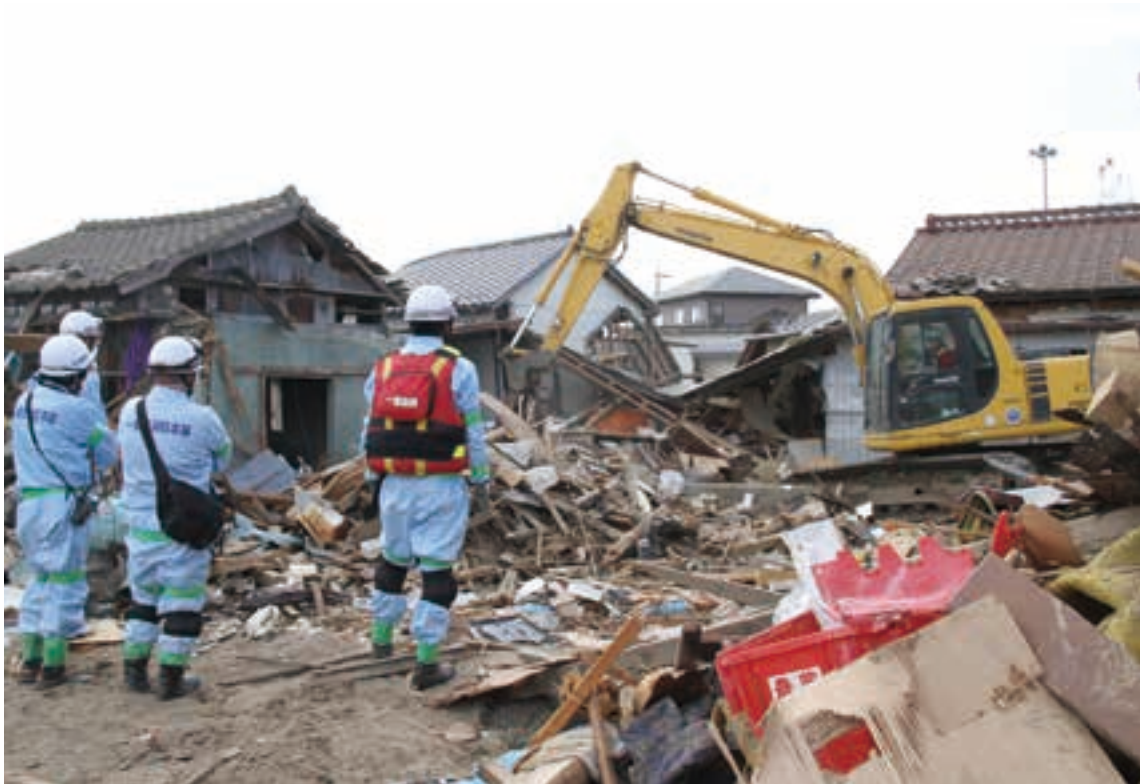
消防の捜索活動と並行して荒浜地区でがれきの撤去が始まった。
