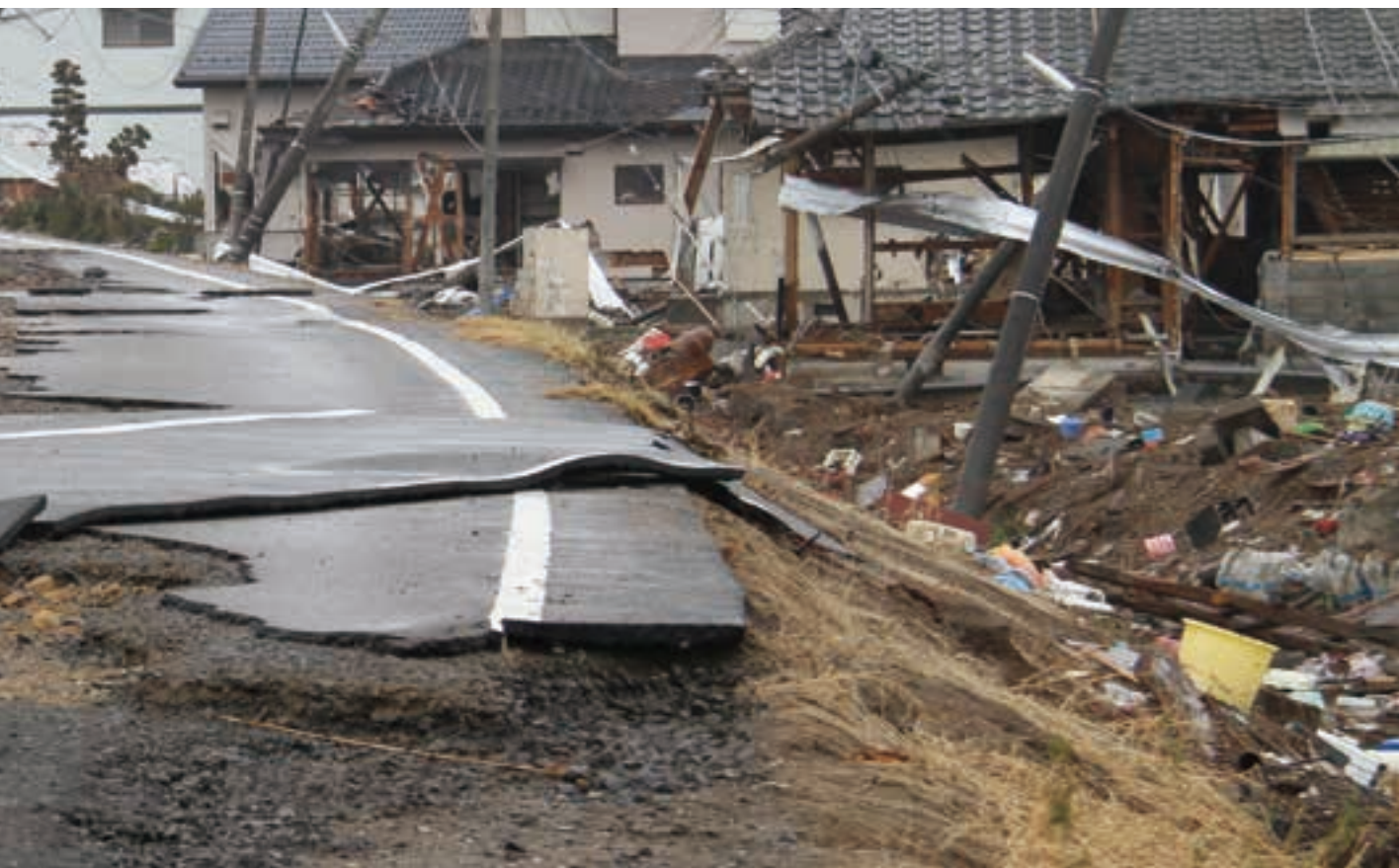
津波の威力により、道路はめくられ、電柱がなぎ倒されている。(荒浜一丁目川口神社付近)
