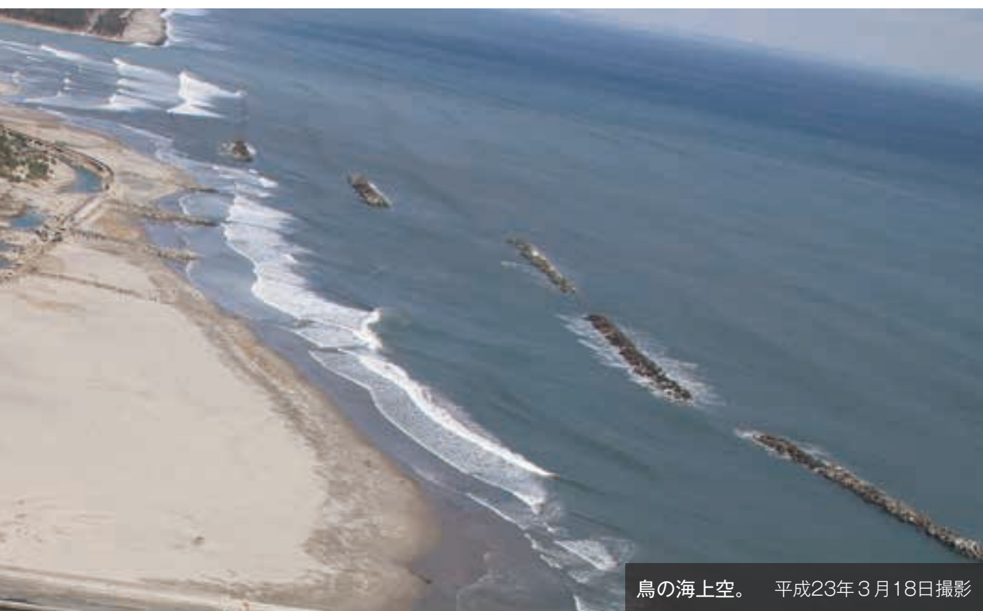
荒浜地区上空。平成23年3月18日撮影
