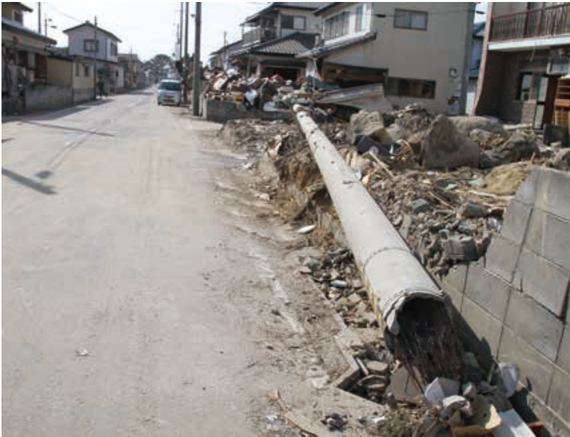
津波によって根元から倒された電柱。(港町)
