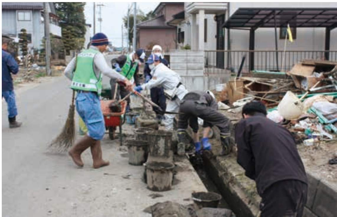
ボランティアによる、側溝の泥掃除を実施。
