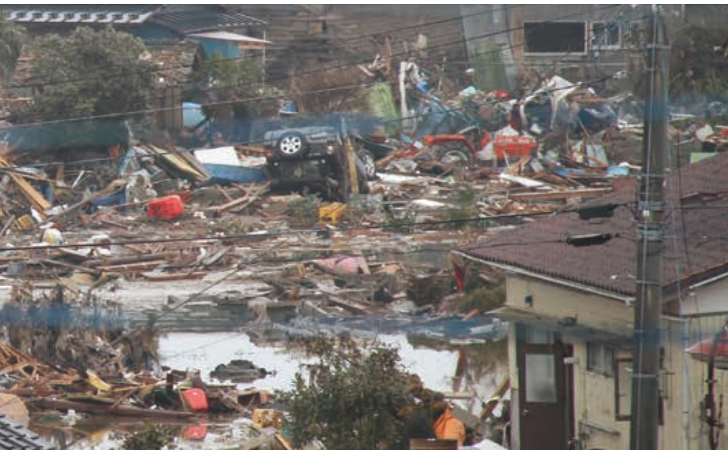
がれきは住宅地の路地まで押し寄せた。
