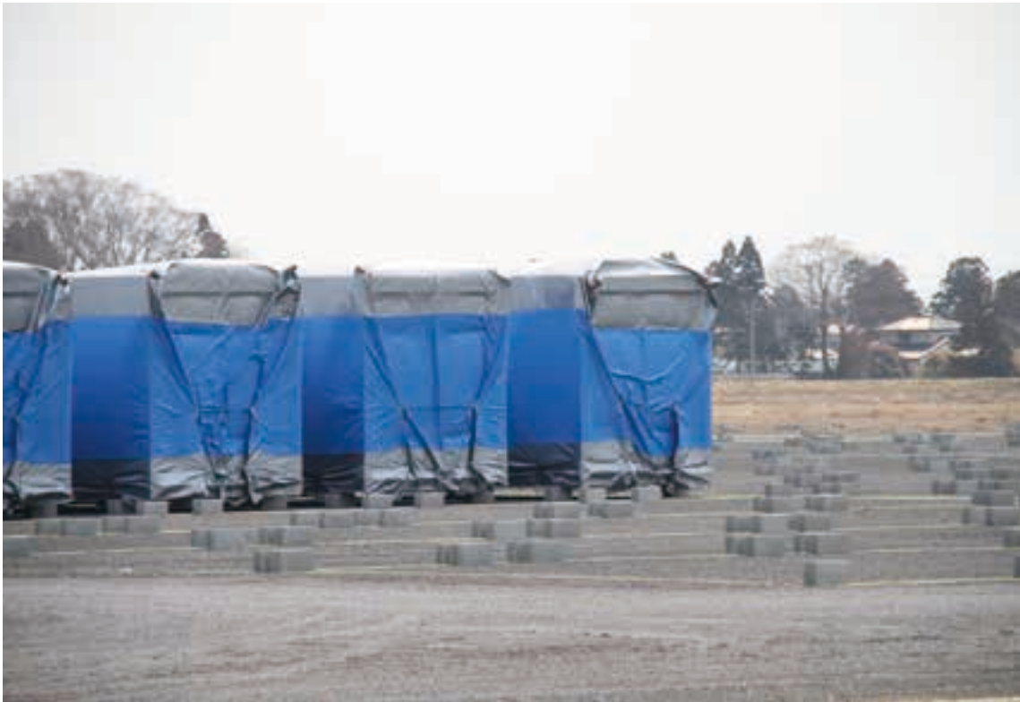
巨理町内で仮設住宅の建設が始まる。
