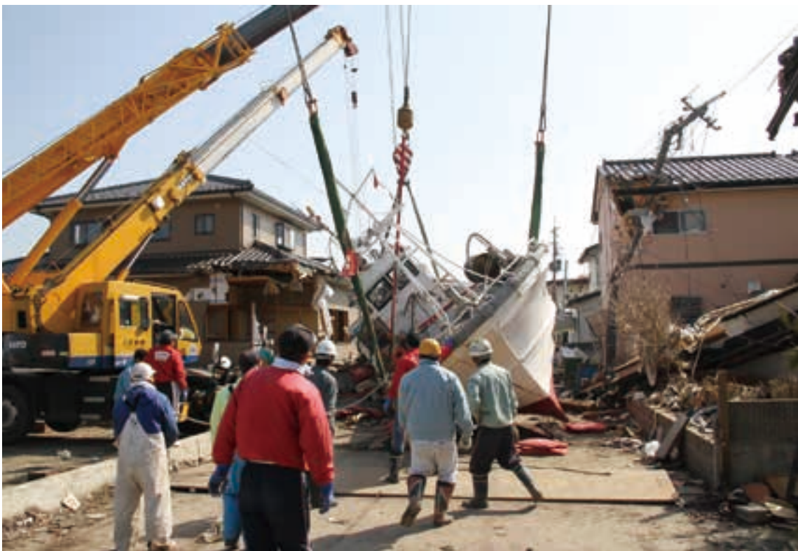
津波で地上に打ち上げられた漁船の撤去作業が行われた。
