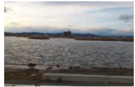
地盤沈下して今も水が引かない荒浜中学校東側の横山地区
