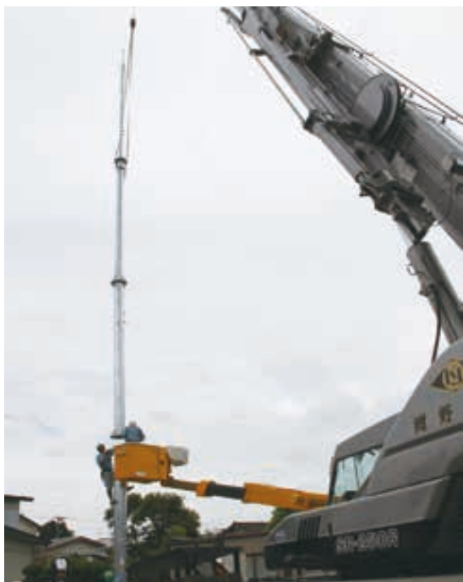
役場庁舎の解体に伴い新たに建てられた防災無線の鉄塔。
