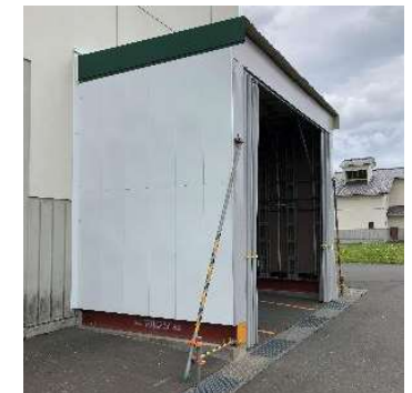
防臭仮囲い設置後
