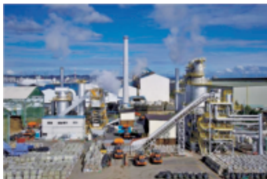
宮城東部ブロックの中間処理施設
