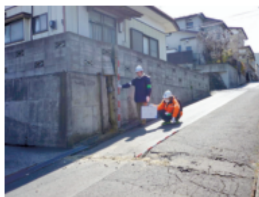
被災宅地危険度判定活動の様子
