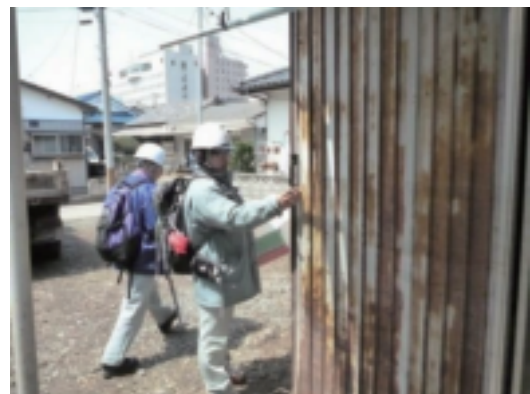
応急危険度判定活動の様子
