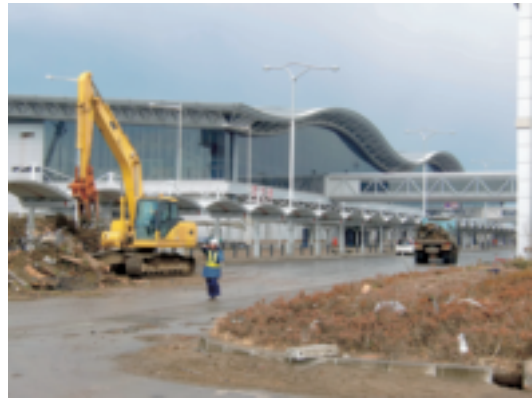
仙台空港の復旧工事の様子
