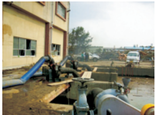
応急ポンプによる排水の様子
