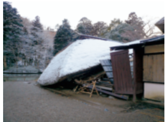
有備館の被災状況(大崎市)
