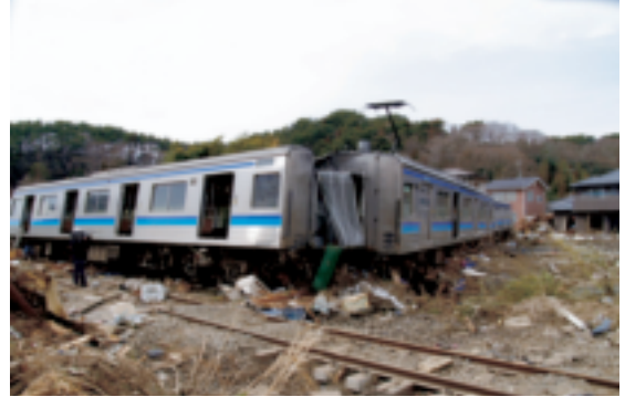
JR 仙石線 津波により被災した電車
