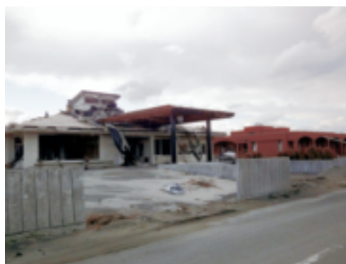
被災した岩沼市デイサービスセンター・赤井江マリンホーム
