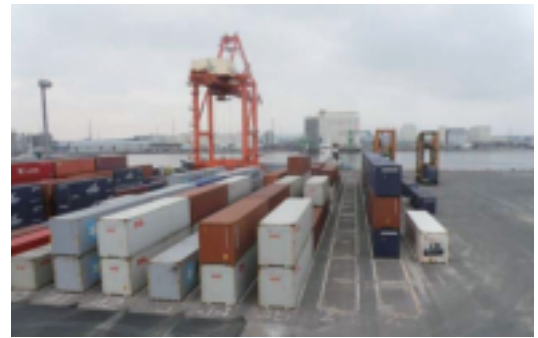
港湾の復旧状況
