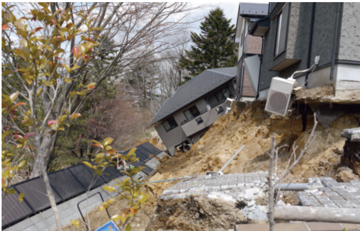
仙台市青葉区西花苑 丘陵部の宅地被害（仙台市）
