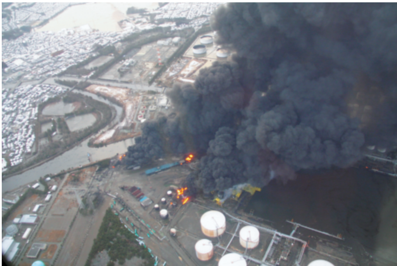
3月11日 黒煙を上げるJX日鉱日石仙台タンク（第二管区海上保安本部）
