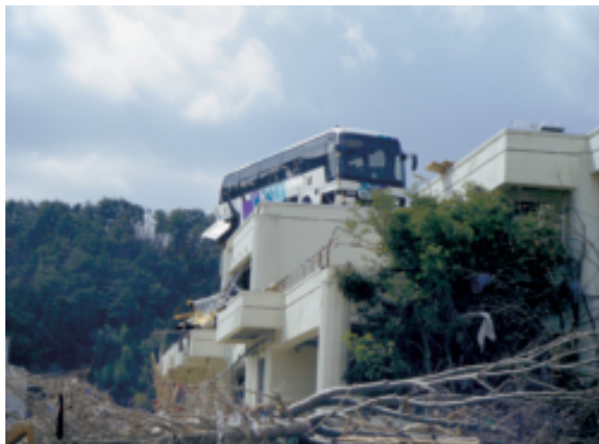
3月18日 津波により雄勝公民館の屋上に乗り上げたバス（石巻市）
