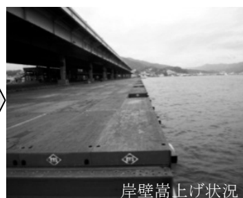
気仙沼漁港の岸壁応急工事状況
