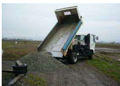
砂利の荷下ろし
