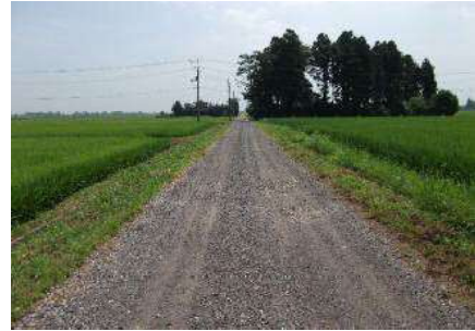
未舗装農道（砂利の路面）
