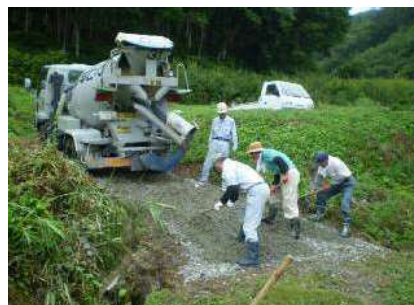
コンクリート舗装状況
