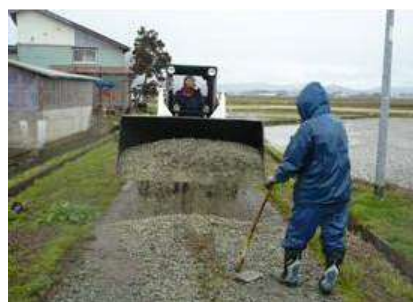
砂利の敷き均し
