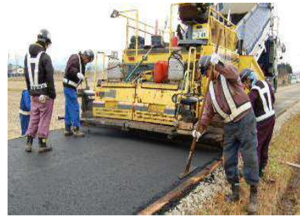
アスファルト舗装状況
