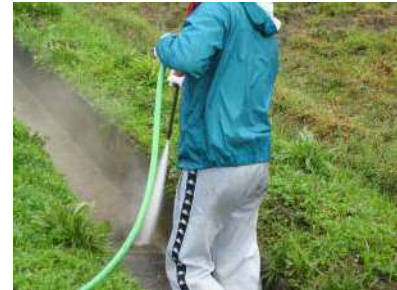
高圧洗浄機による 水路内の清掃
