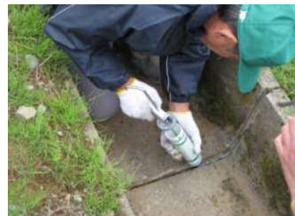
シーリング材充填
