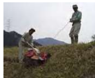
小段設置状況（掘削）
