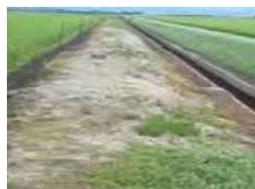
景観悪化の状況
