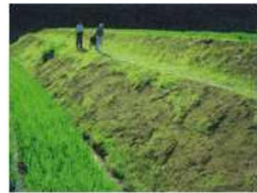
小段が設置されている法面
