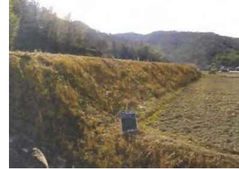
高低差のある畦畔法面
