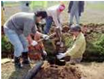
魚道の設置状況
