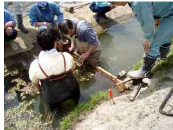
魚道の設置状況（堰板の設置）
