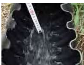
通水試験（水深確認）
