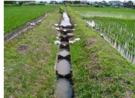
水路魚道（排水路堰上施設）
