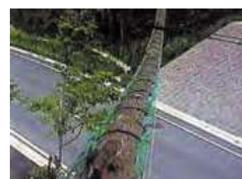
橋梁設置例 （出典：清水建設）
