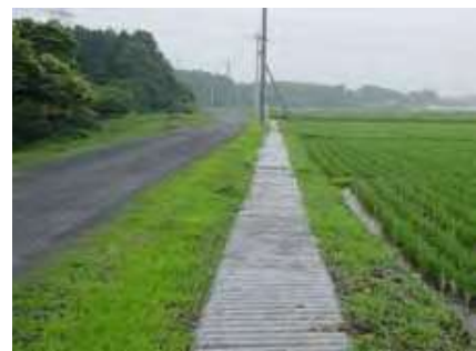
水路へのコンクリート蓋の設置
