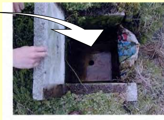
排水調整板設置状況
