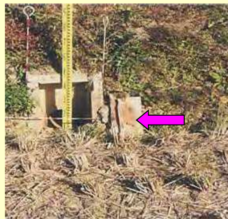
排水調整板設置状況
