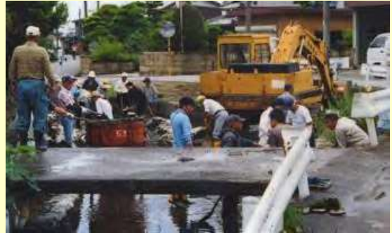
集落での泥上げ作業
