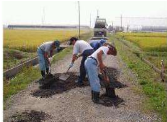
共同作業による砂利の敷き均し
