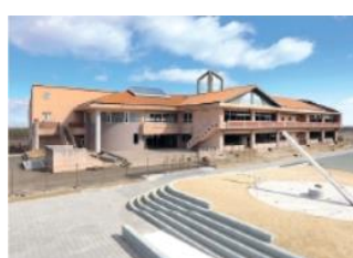
震災遺構中浜小学校 (山元町)
