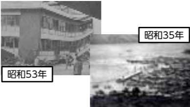
昭和53年 チリ地震津波(気仙沼魚市場付近)㊦、宮城県沖地震(仙台市内)㊦による被害
