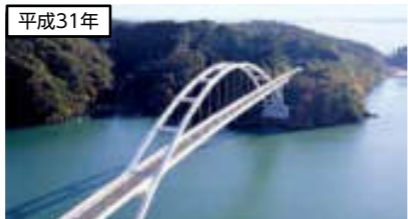
平成31年 気仙沼大島大橋開通 東北最大の有人島である大島と本土を結ぶ通称「鶴亀大橋」
