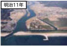
野蒜築港計画が始動(築港跡) 明治政府による東北開発の重点政策として計画されたが、明治17年の台風被害により中止されました
