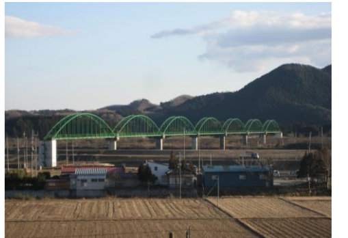
< 阿武隈川水管橋 >
