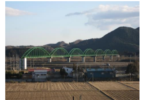
＜ 阿武隈川水管橋 ＞
