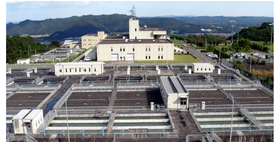
＜ 南部山浄水場 ＞
