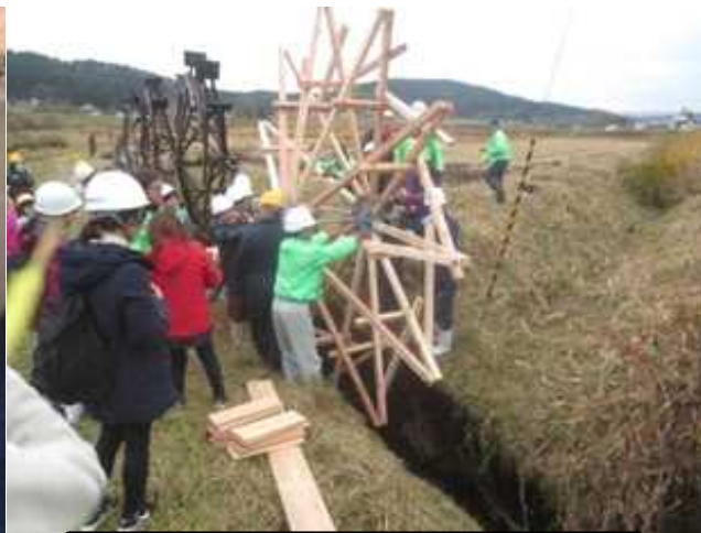
完成した水車を現地に設置
