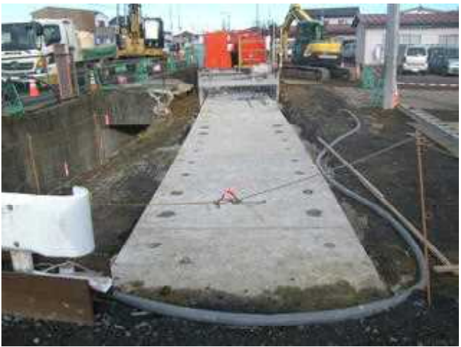
都市下水路の施工状況②
