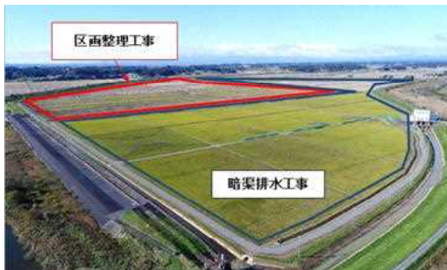
迫第四地区の今後の工事区域
