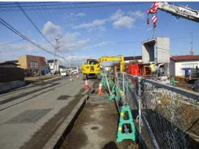
都市下水路の施工状況①
