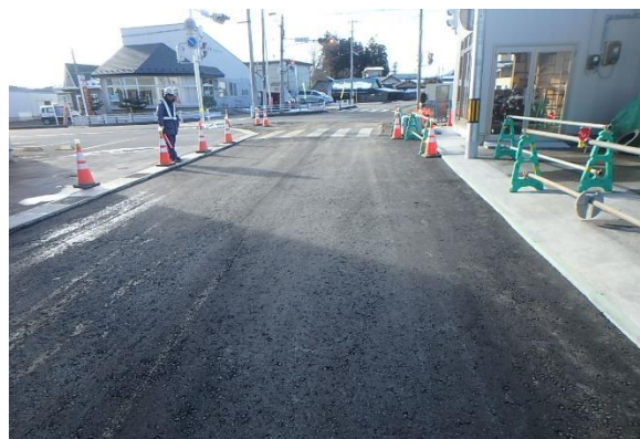
交差点改良工事の状況
