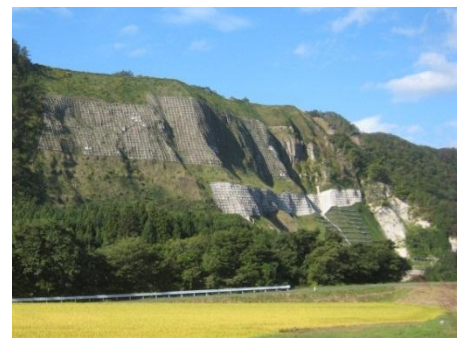
花山地区での山地災害復旧工事の状況
