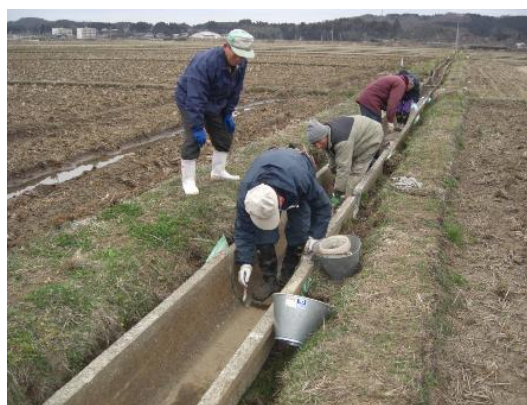
地域活動で、水路の補修作業
