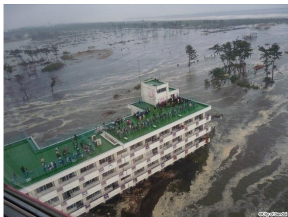
津波で孤立する荒浜小学校
