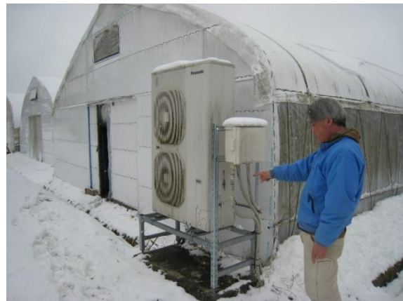
【施設の屋外設備の確認状況】
