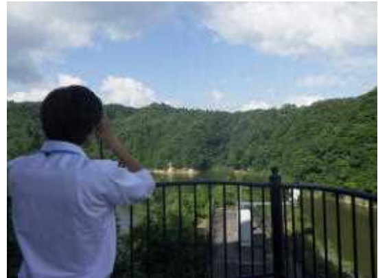
【新たに花山ダム周辺での被害を確認】
