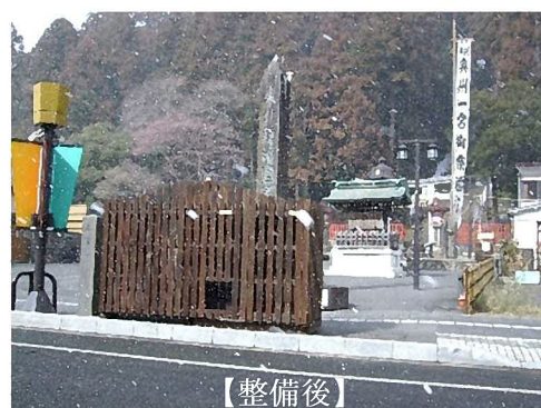
地上機器に覆いを設置した事例（（都）北浜沢乙線）
