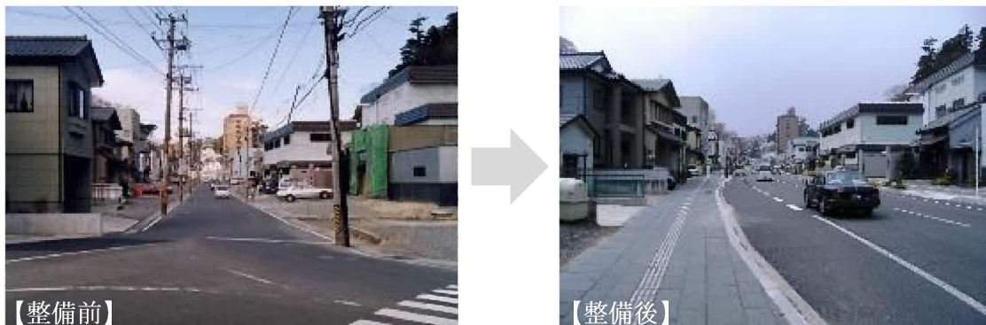
良好な景観形成の事例（（都）北浜沢乙線）
