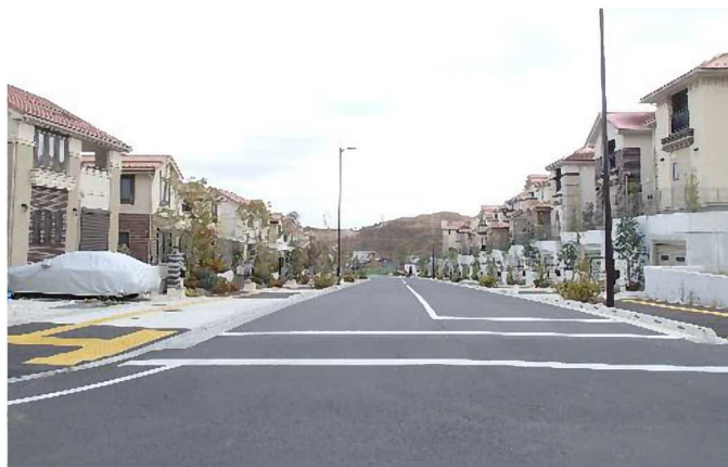
区画道路の無電柱化事例
