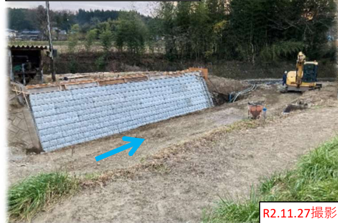
伊手川 96号 実施状況
