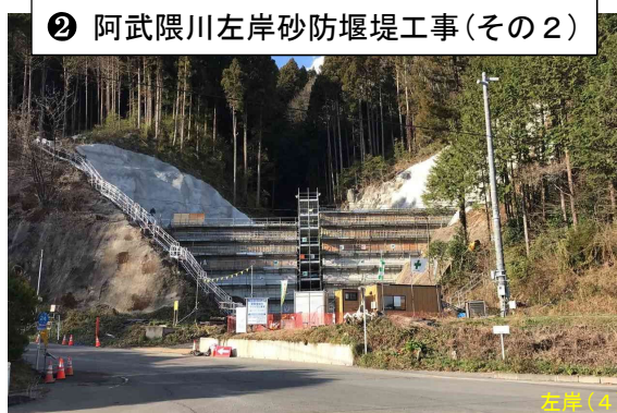
砂防堰堤工 (型枠・コンクリート)
