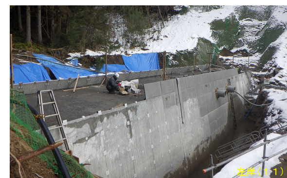
砂防堰堤工 (型枠・コンクリート)
