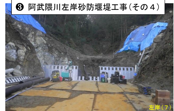
砂防堰堤工 (型枠・コンクリート)
