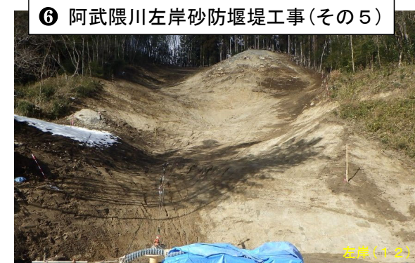
山腹工 (法面整形)
