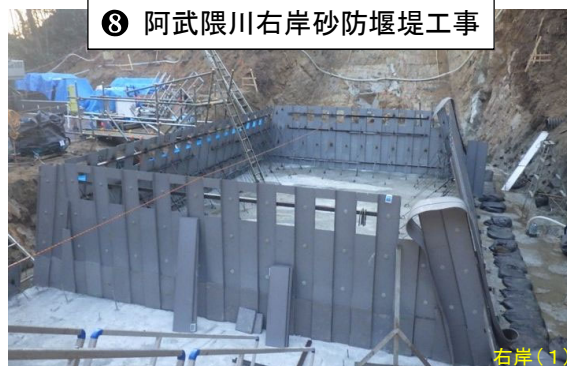
砂防堰堤工 (型枠・コンクリート)
