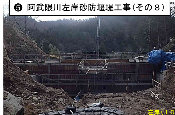
砂防堰堤工 (型枠・コンクリート)
