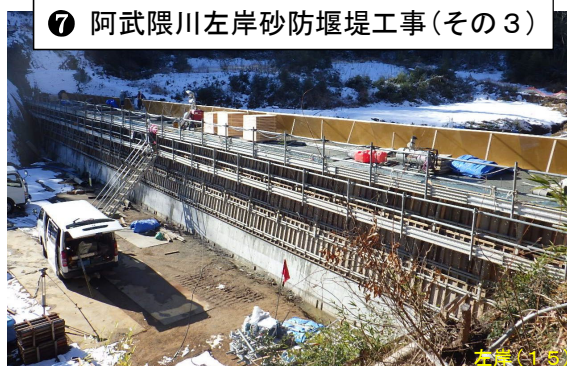
砂防堰堤工 (型枠・コンクリート)
