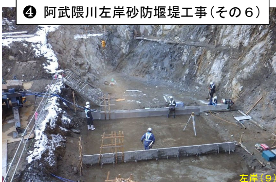
砂防堰堤工 (型枠・コンクリート)
