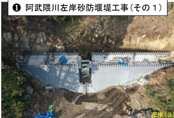
砂防堰堤工 (型枠・コンクリート)
