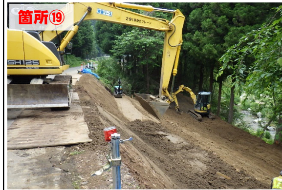
法面整形作業
