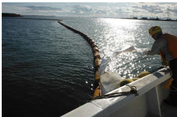
油吸着マット投入作業の様子
