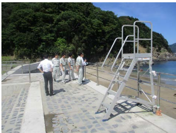
雄勝港浪板防潮堤災害復旧工事現場を視察
