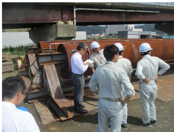
石巻港東浜防潮堤工事現場を視察
