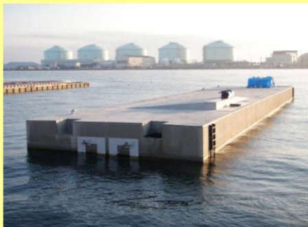
浮棧橋仮係留状況
