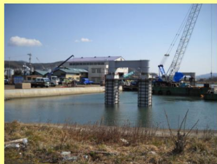
浮棧橋設置箇所整備状況
