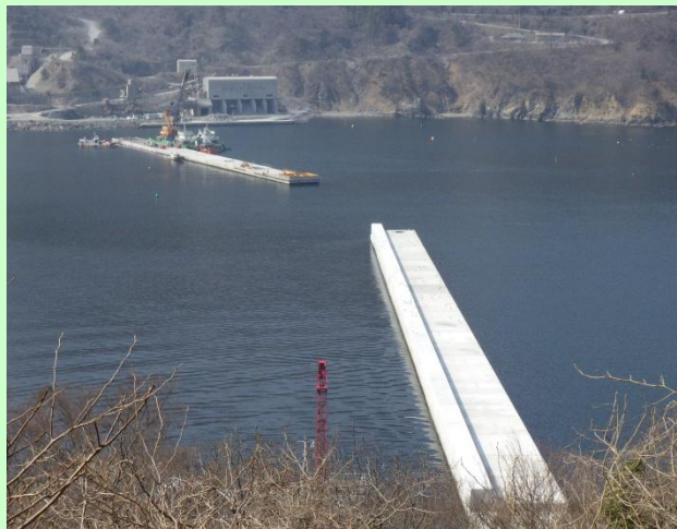
○女川湾口防波堤（28 箇中 25 箇据付けが完了）
