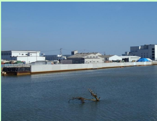
⑥重吉防潮堤 平成27年3月完成
