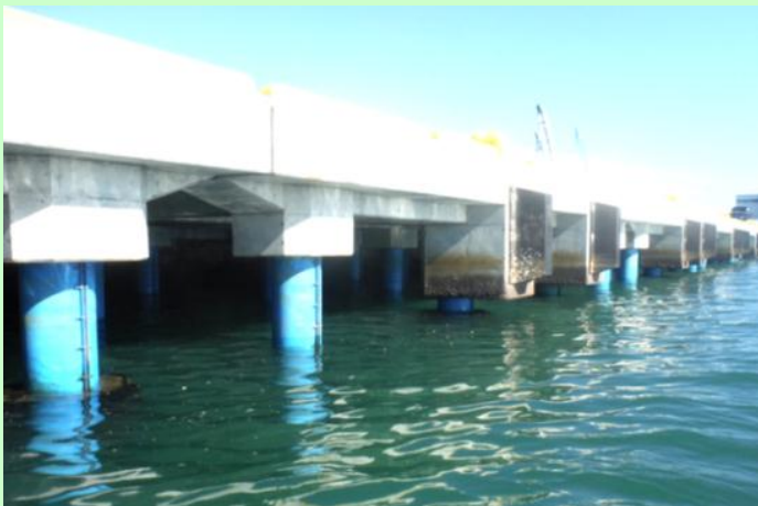
◎大手岸壁-7.5m 防食 平成 26 年 12 月完成
