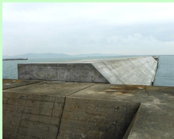
⑧西防波堤 平成26年12月完成
