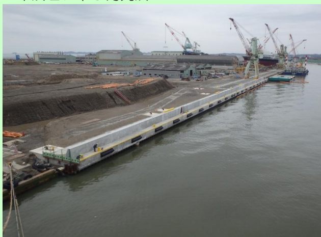
⑦西水路南地区(その1)防潮堤 平成27年3月完成
