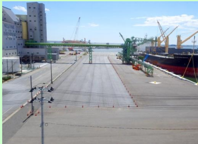
◎日和埠頭荷捌地 平成 26 年 11 月完成
