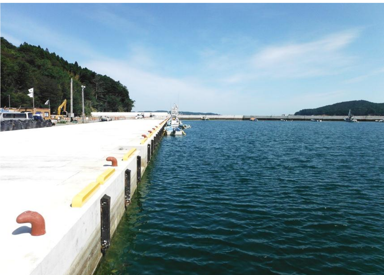
横浦地区 防波堤と-2m物揚場の嵩上げ復旧が完了
