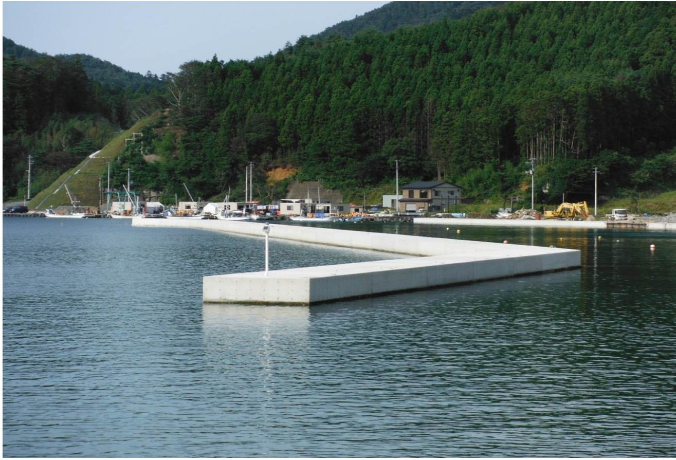
立浜地区 防波堤(L=470m)の嵩上げ復旧が完了
