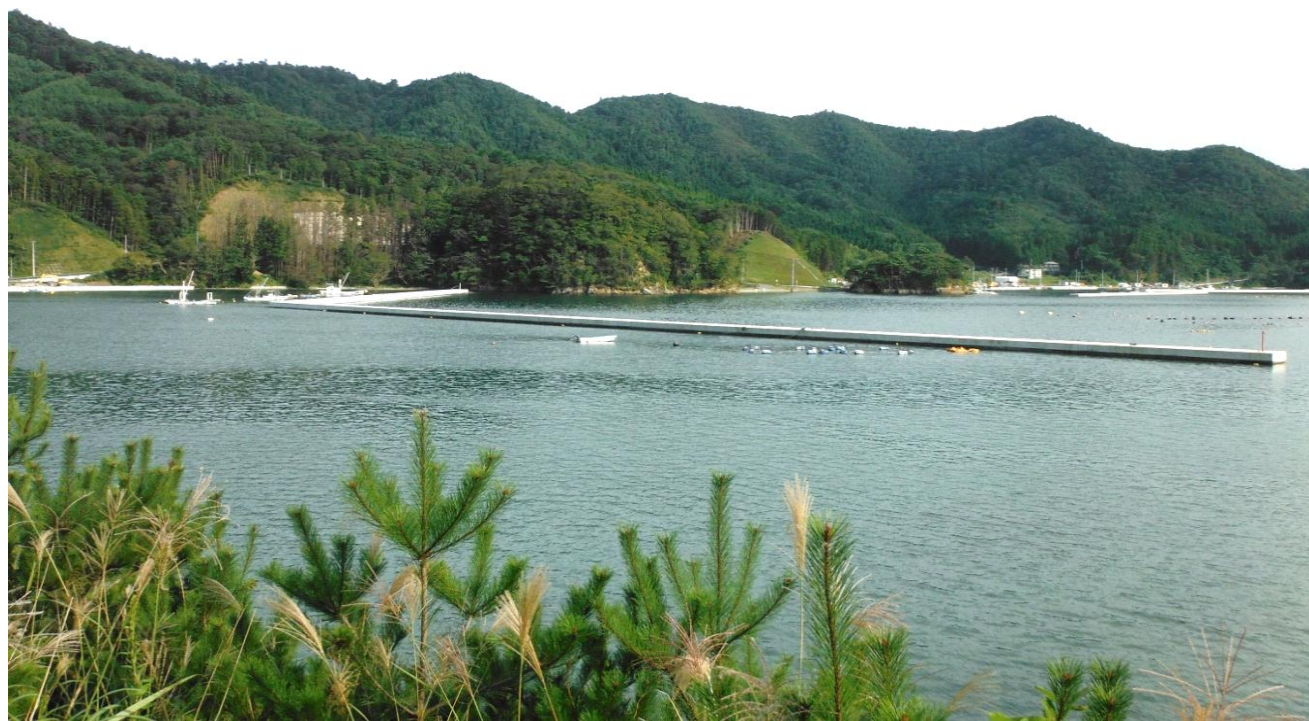
大浜地区 防波堤(L=385m)の嵩上げ復旧が完了
