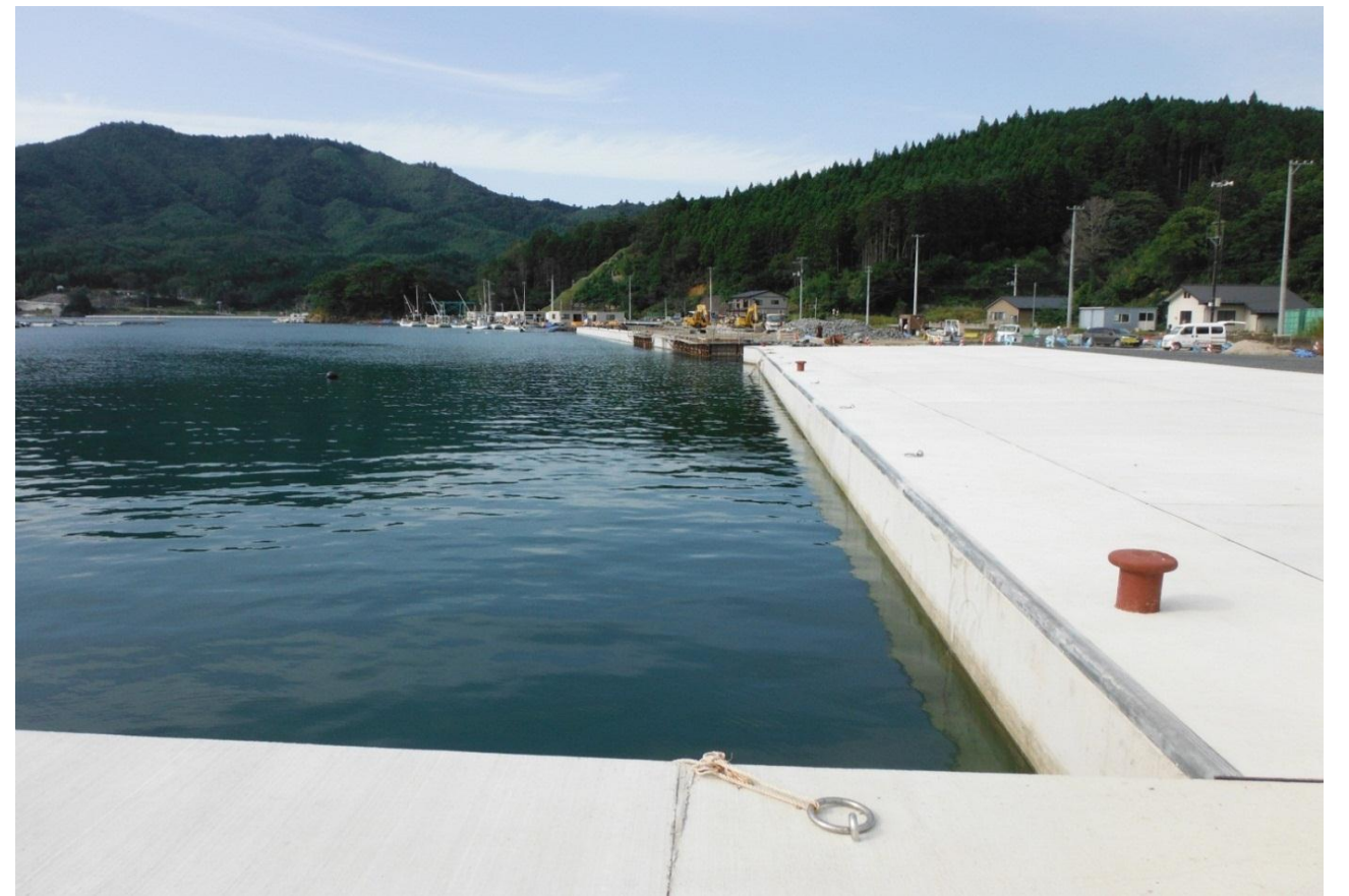
立浜地区 (-1.5m)物揚場の嵩上げ復旧が完了
