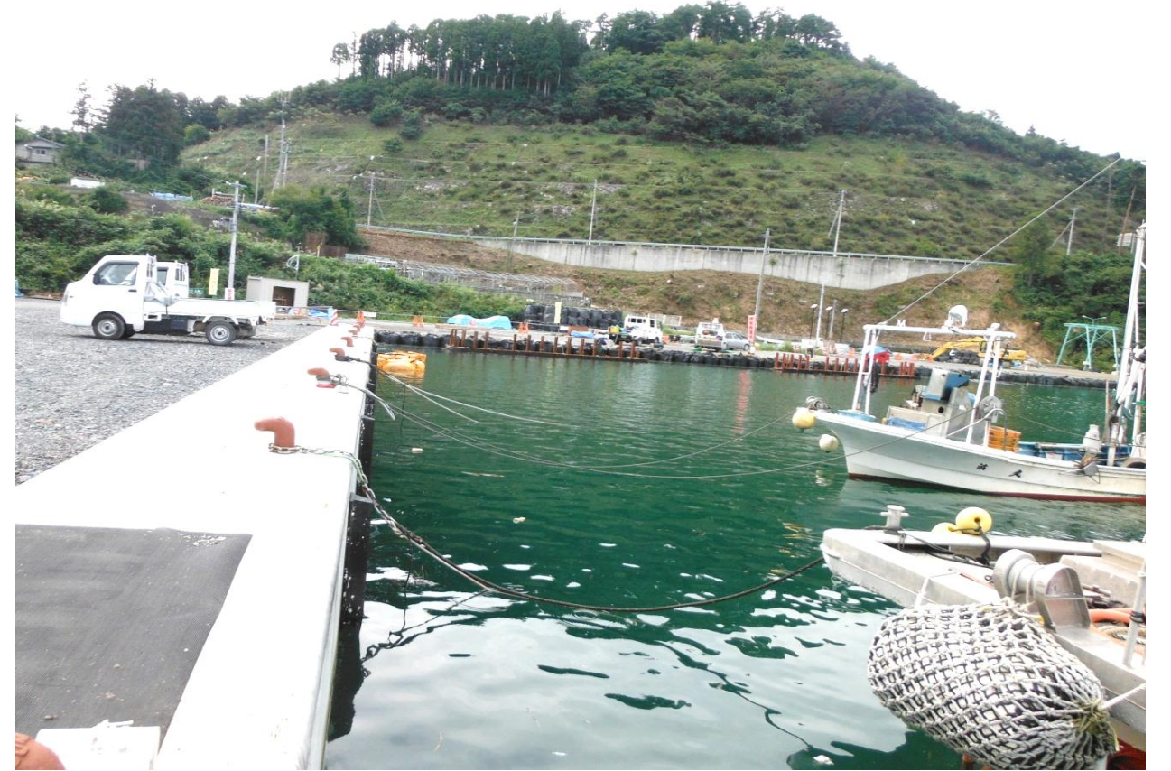
水浜地区 物揚場の嵩上げ復旧が進行中
