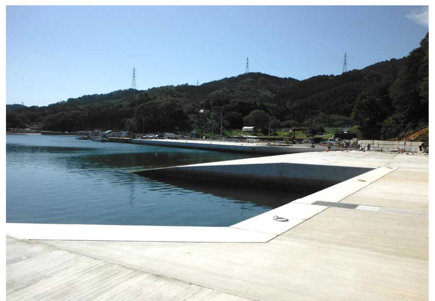
大石原地区 一部物揚場の嵩上げ復旧が完了
