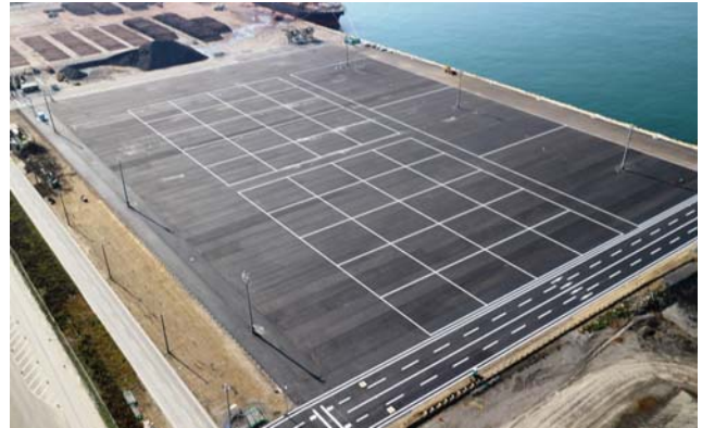
雲雀野中央荷捌地災害復旧(その2)工事 11月8日完成
