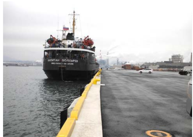
南浜2号岸壁 12月10日より供用開始
