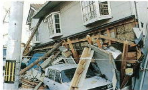
地震による被害例（阪神・淡路大震災）
