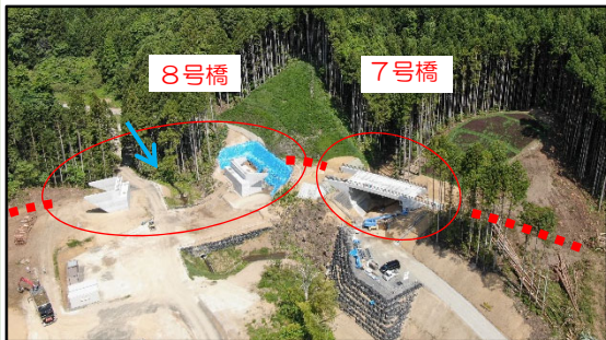
橋梁下部工工事(7号橋, 8号橋)
