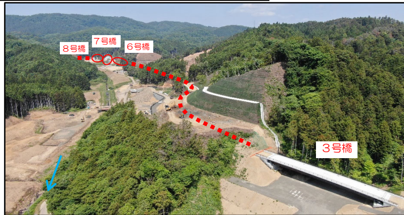
付替道路全景(ダム建設位置~8号橋)
