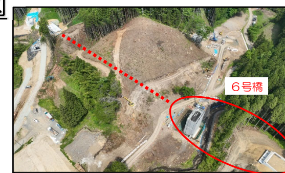
①6号橋下部工工事
