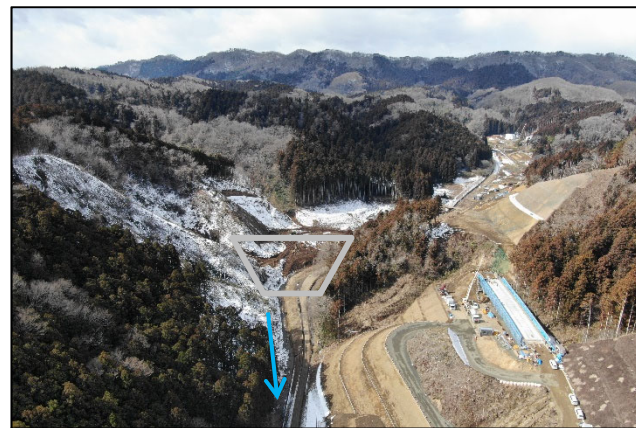
ダム建設位置
