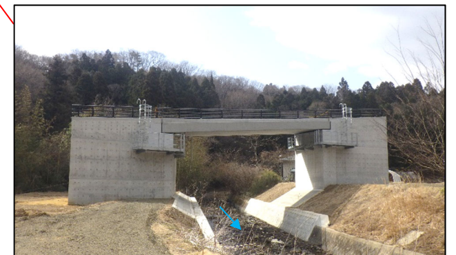
橋梁工事 (2号橋)
