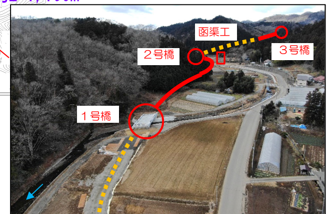
道路改良工事 (1号橋~2号橋区間)
