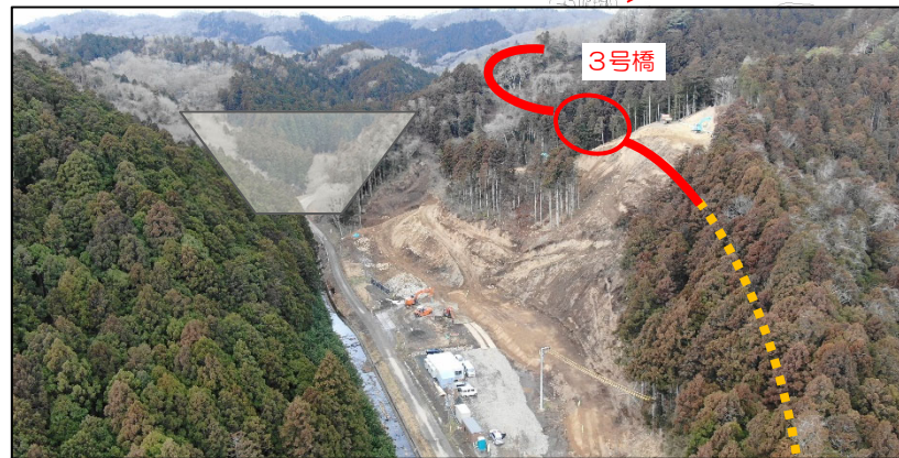
3号橋下部工・道路改良工事 (2号橋~3号橋区間)
