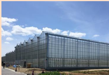
【令和3年6月に完成した複合環境制御システムを有するフェンロー型ガラスハウス 〔(株)デ・リーフデ大川〕
