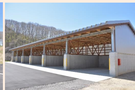
新たに整備した堆肥舎
