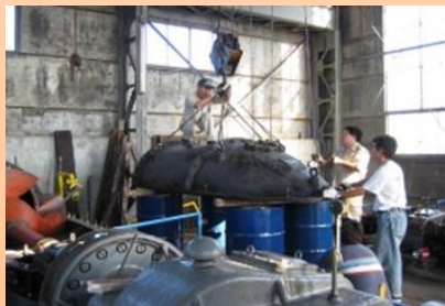
【排水ポンプの分解整備】
