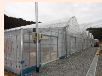
整備した丸型鉄骨ハウス
