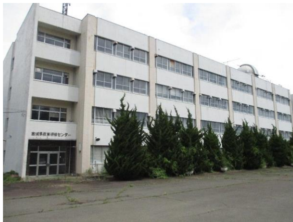
<旧教育研修センター跡地の状況>
