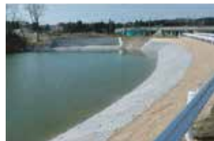
整備された農業用ため池
