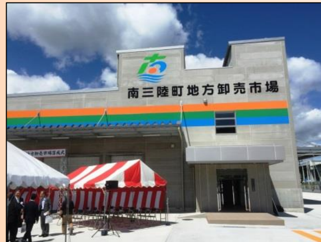
新しくなった志津川魚市場
