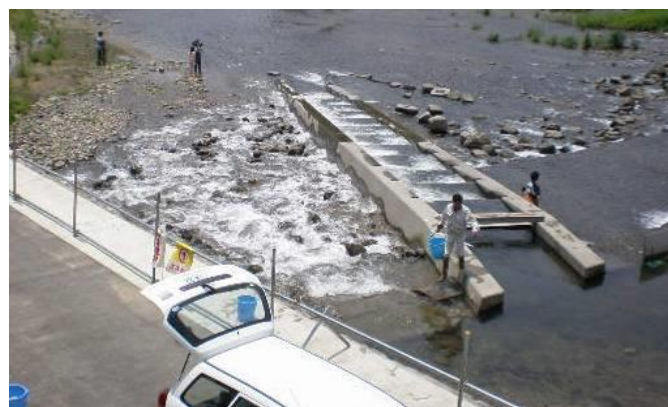
改修された魚道の調査
