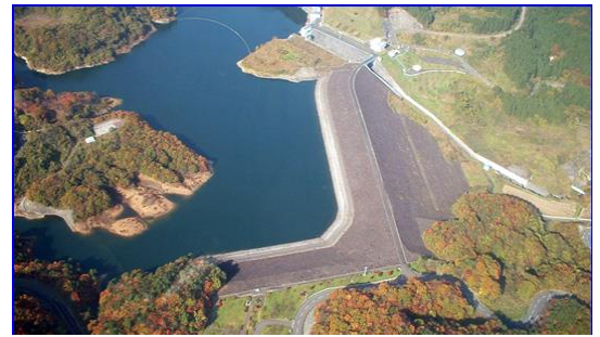
▲七北田ダム、南川ダム、宮床ダム、惣の関ダム（自然調節方式ダム） 写真は七北田ダム
