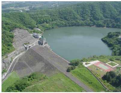
▲樽水ダム（ゲート操作方式ダム） 通常時はゲート操作しない一定開度方式による洪水調節
