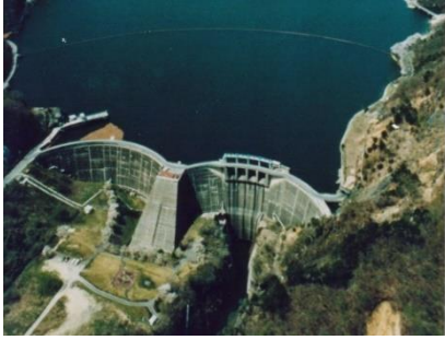
▲大倉ダム（ゲート操作方式ダム） 一定率一定量方式によるゲート操作で洪水調節
