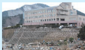
津波に流された自動車が法面に…。 出所：東日本大震災アーカイブ宮城(女川町) 提供者：女川町
