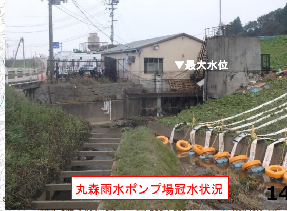
丸森雨水ポンプ場内冠水状況
