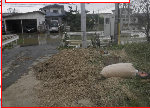
角田市岡地区 汚水マンホールポンプ
