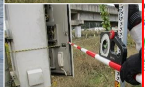
制御盤内浸水状況
