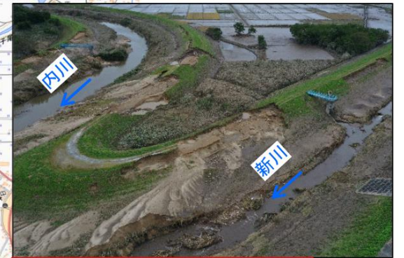
新川・内川合流点: 堤防決壊 (宮城県丸森町 愛宕田 地先)
