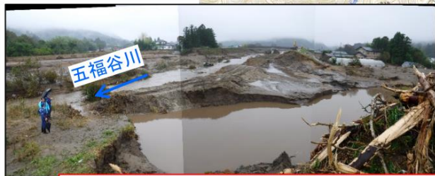
五福谷川: 堤防決壊 (宮城県丸森町 畑中～馬淵 地先)
