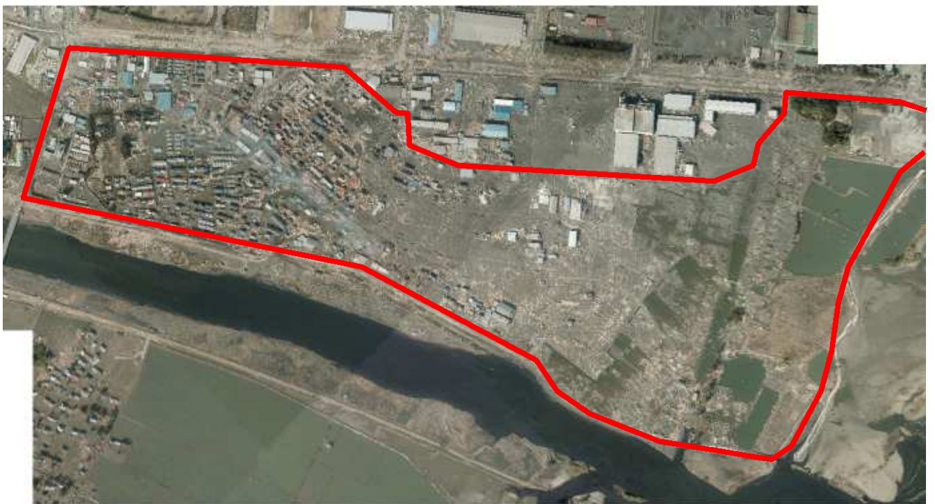
区域全景【被災直後】
