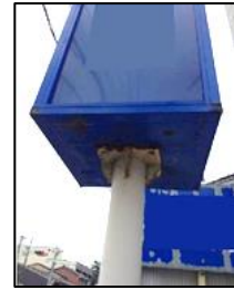
支柱・広告板接合部
