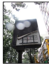
シート材がはがれかかった状態
