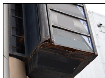
側板底面が腐食、破損した状態
