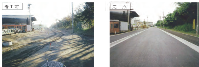
①区画道路 12-7 舗装工事
