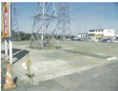
①1 街区整地工事完成
