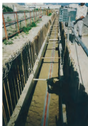
⑤区画道路 18-2 下水道工事
