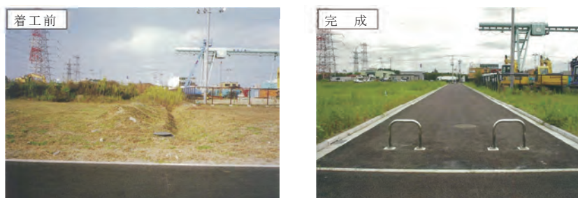
②特殊道路 6-1 舗装工事
