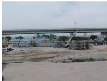
工事が進んでいる仙台港 IC
