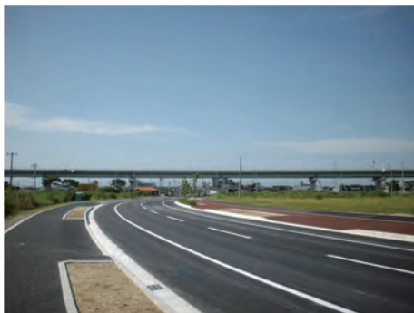
開通したポートセンター南線
