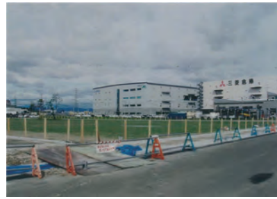
②5号公園整地工事完成
