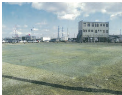
②12 街区整地工事完成
