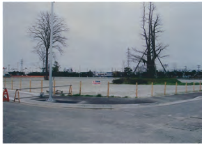
①2号公園整地工事完成
